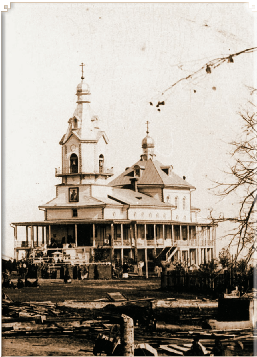
Строительство храма Иверской иконы Божией Матери
